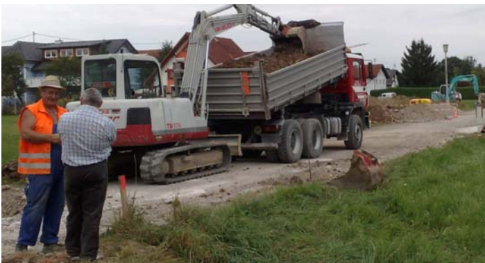
Fertigstellung der Hessengasse
