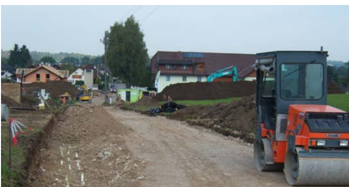
Die Pausingergasse wurde im Rohbau verlängert
