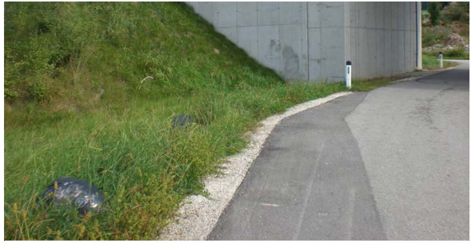
Illegale Müllentsorgung entlang des Zubringers zum Altstoffsammelzentrum
