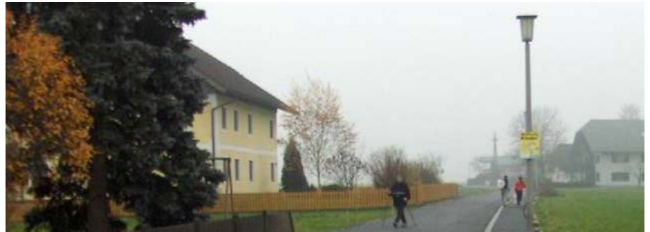
Der neue Gehweg bringt mehr Verkehrssicherheit in der Schulstraße
