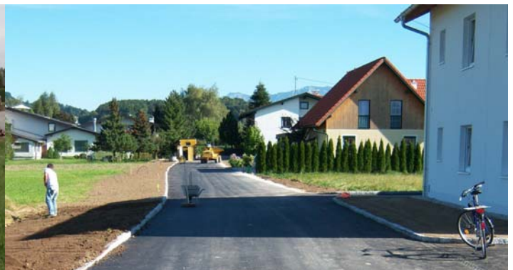
Die Rainergasse wurde ebenfalls fertig gestellt
